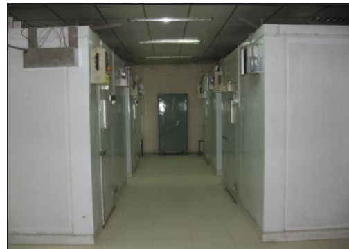
चित्र 1.109 : आलू के लिए पर्यावरणीय ढंग से नियंत्रित चैम्बर for potato storage
