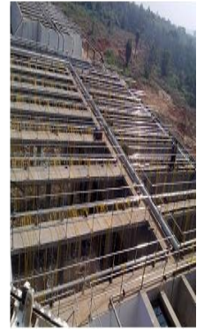
चित्र 1.24 सीएसआईआर – एन ई ई आर आई द्वारा तैयार की गई प्रक्रिया के आधार पर नागार्जुन कृषि रसायन लिमिटेड श्रीकाकुलम में (क) अमोनिया स्ट्रिपर और (ख) दो स्तरीय बायो आक्सीडेशन (टी एस बी) को शामिल करके पूर्ण स्तर की 600 क्यूबिक मीटर/प्रति दिन निर्धारित क्षमता की ई टी पी प्रक्रिया को कार्यान्वित किया गया है।
