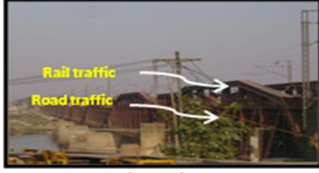
यमुना नदी पर स्टील ट्रस पुल
